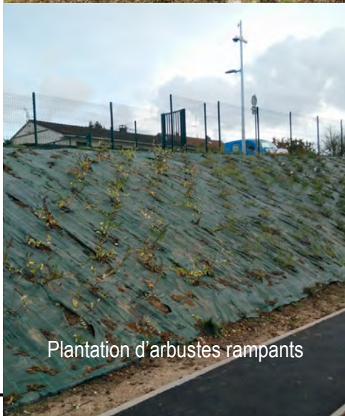
Réalisation d'un drainage renforcé sur le terrain engazonné
