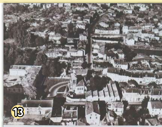
Les toits typiques de la SCI des Brosses
