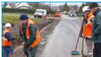
Viabilisation de la route de Seranville
